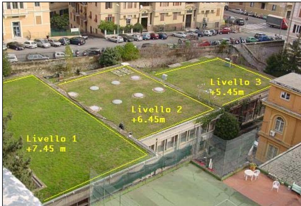
Figura 1: Stato del sito antecedente le lavorazioni per l'installazione del sito sperimentale.
