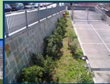
Copertura erbacea arbustiva e superficie asfaltata
