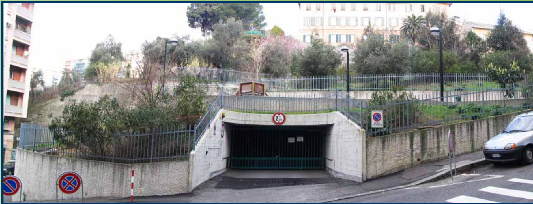
Involucro edilizio e copertura
