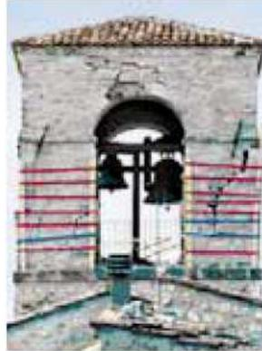
tirantature metalliche (o cerchiature globali), che, oltre a non determinare ingombri sugli spazi prospicienti la struttura, sono pienamente idonee ai fini della resistenza dell'edificio rispetto a ulteriori scosse sismiche e, se opportunamente progettate, potrebbero essere integrate nell'intervento definitivo.
