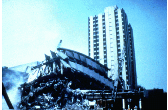
Messico City, 1985 (M=8.1) Edificio di 21 piani in acciaio
