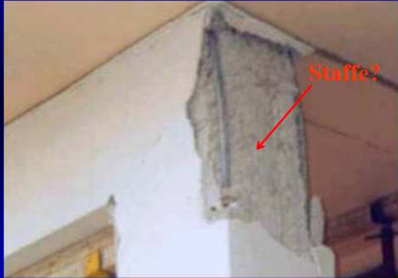
Figura 8.10. – Tipico collasso di nodi esterni senza staffatura di telai in c.a.
