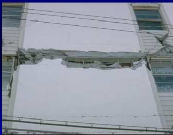
Figura 8.19. – Rottura giunto di collegamento
