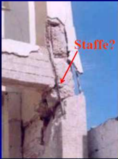
Figura 8.10. – Tipico collasso di nodi esterni senza staffatura di telai in c.a.
