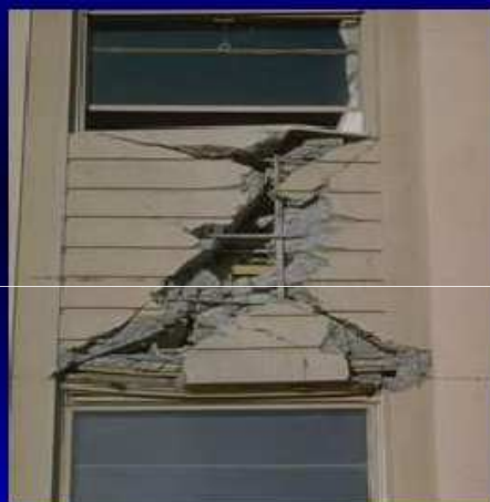
Figura 8.18. – Rottura per taglio
