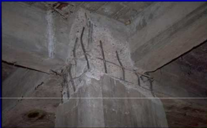
Figura 8.10. – Tipico modo di collasso di un nodo interno di un telaio in c.a.
