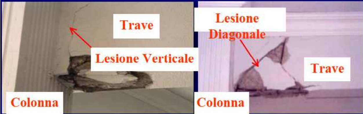
Figura 8.3. – Rottura per flessione.
