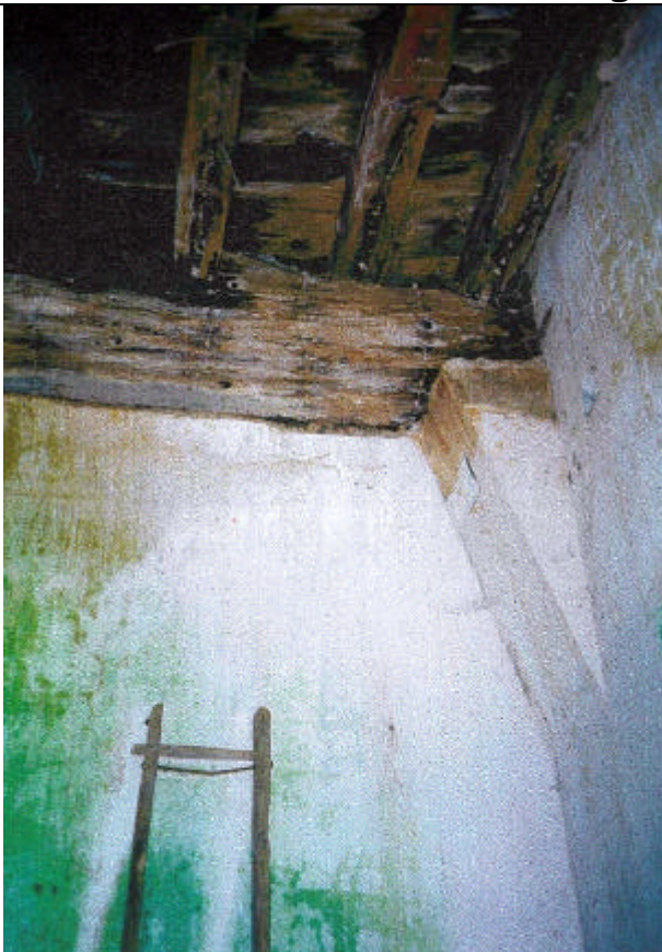
Edificio - Arenzano (Ge)
