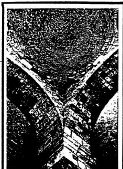
Cagliari, basilica di S. Satur- no, particolare del raccordo angolare "a fazzoletto" (sec. XII). (5)
