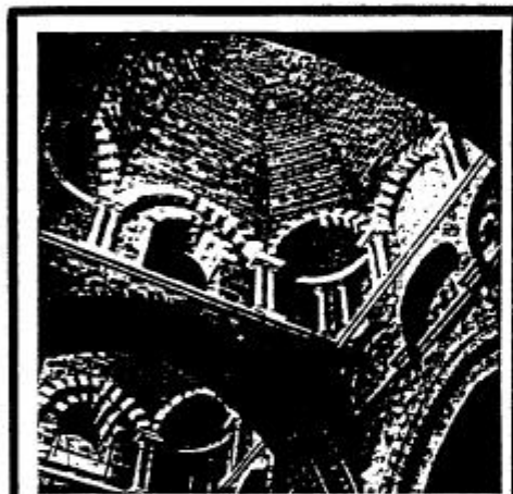
Le Puy (Francia) cattedrale, particolare della risoluzione d'angolo dei padiglioni di copertura (sec. XI-XII). (5)
