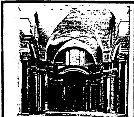
Roma, aula termale di Diocleziano trasformata da Michelangelo nella chiesa di S. Maria degli Angeli (1561). La forma canonica del frigidarium delle Terme romane prevede una copertura composta da tre ampie crociere affiancate. (5)
