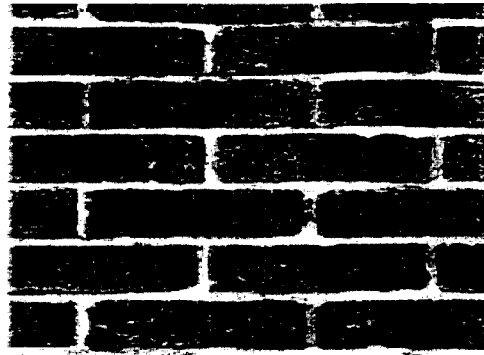
Muratura in mattoni
