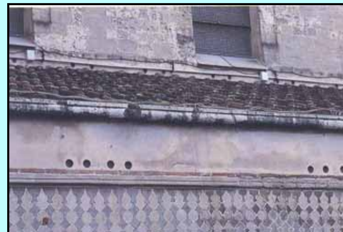
FORI DI VENTILAZIONE COPERTURA
