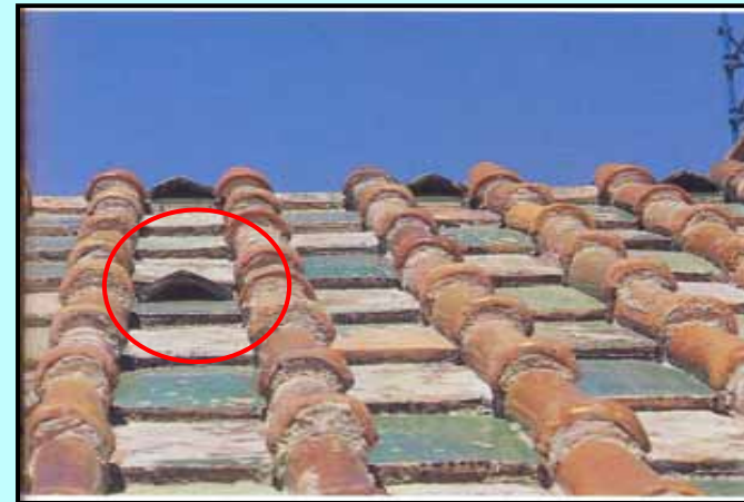
BOCCHHE DI VENTILAZIONE MANTO DI COPERTURA
