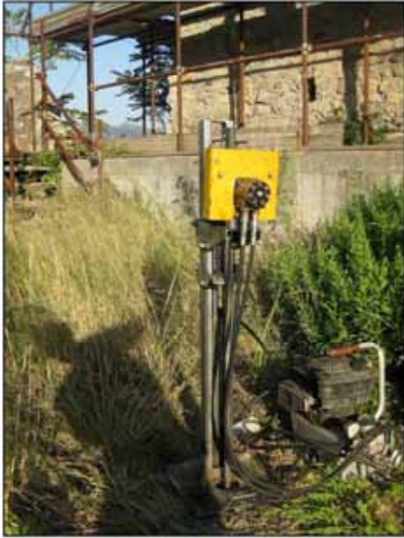
Figura 4: Esecuzione Prova 1 - Prospetto S
