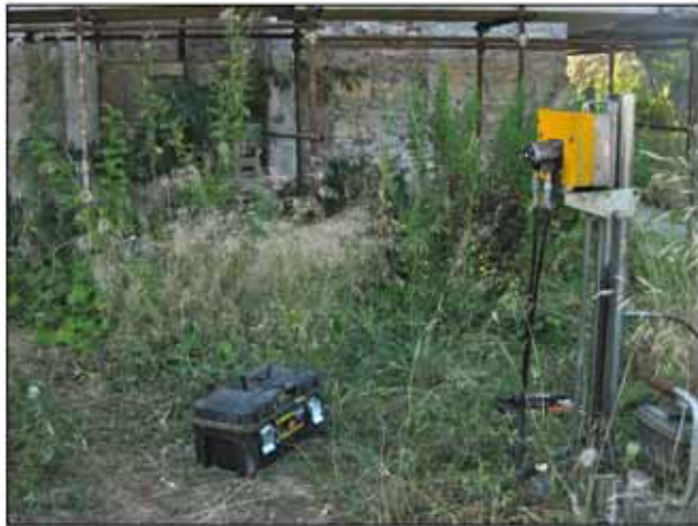
Figura 5: Esecuzione Prova 2 - Prospetto N
