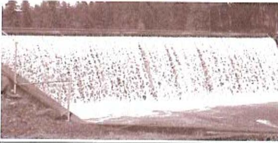
**ESERCIZIO 5.** Il rilascio d'acqua da una diga avviene – a bacino pieno – su una larghezza di 20 m con una portata di  $125 \text{ m}^3 \text{ s}^{-1}$ . Un modello in scala 1:15 viene costruito per studiare le caratteristiche dello sfioratore. Trascurando gli effetti di viscosità e tensione di superficie, si determini la larghezza del modello e la portata. Per un intervallo di tempo nel prototipo pari a  $t_p = 24 \text{ h}$  quale sarà il tempo  $t_m$  nel modello?
