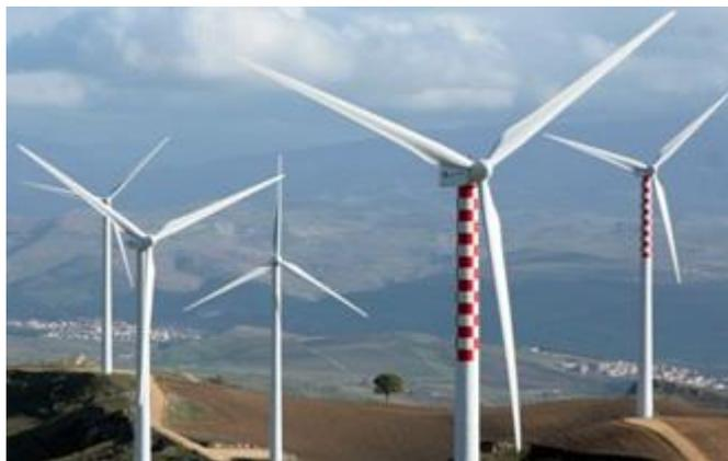
*Fig. 2.2 - Turbine ad asse orizzontale*
