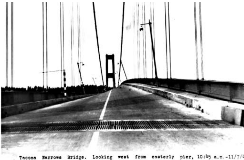
Figura 1.1. Torsione del ponte Tacoma causata dal carico del vento
