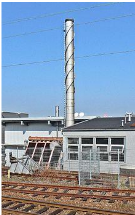
Figura 1.1 Camino con filetti elicoidali.
