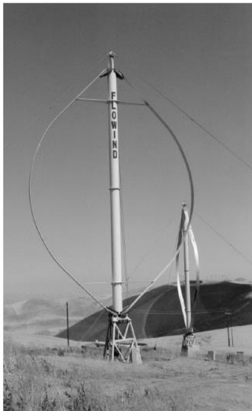
Figura 1.4 Turbina eolica ad asse verticale tipo Darreius
