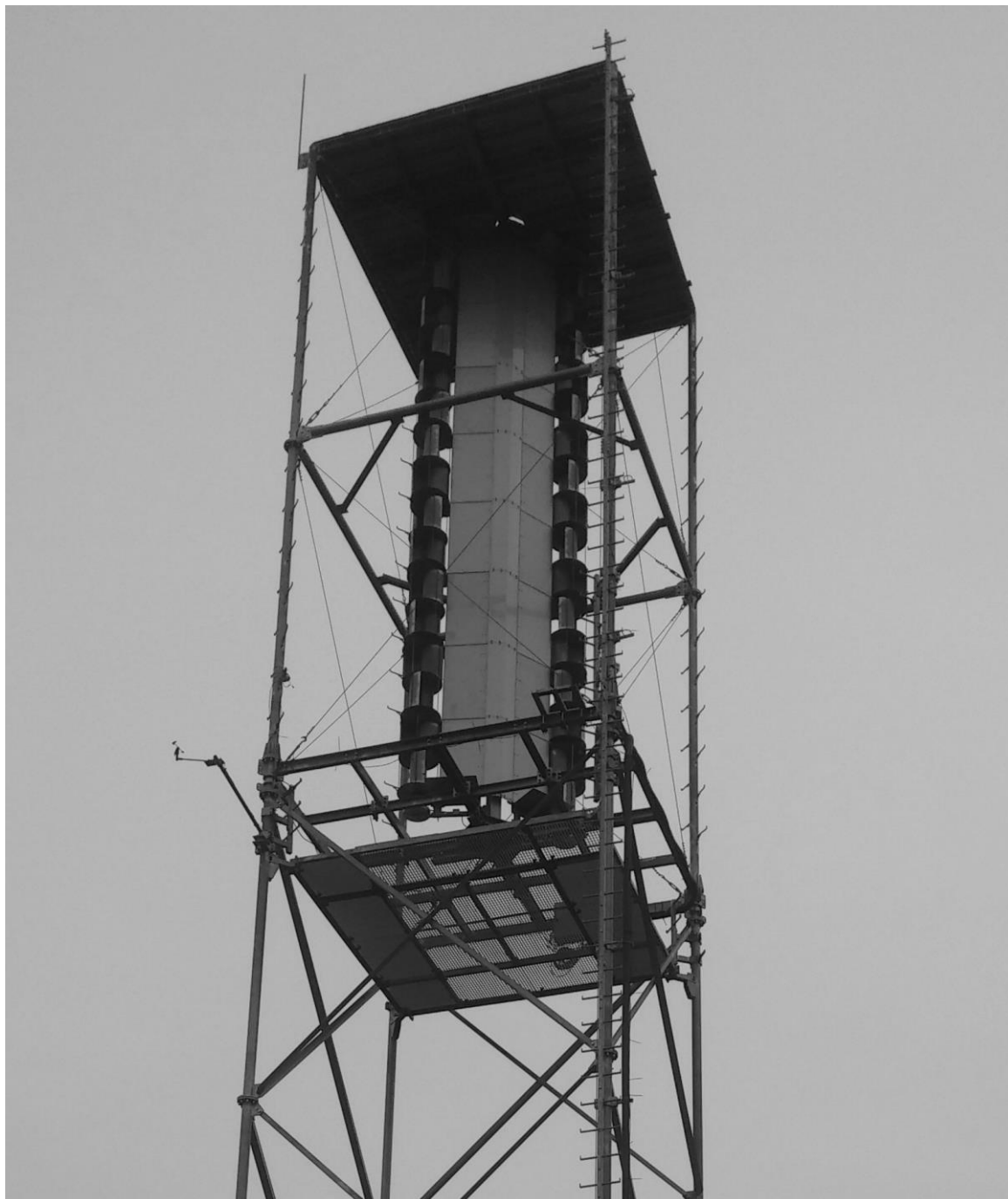
Fig. 3.3:impianto reale per la turbina innovativa; altezza rotori 4m, altezza complessiva 26m
