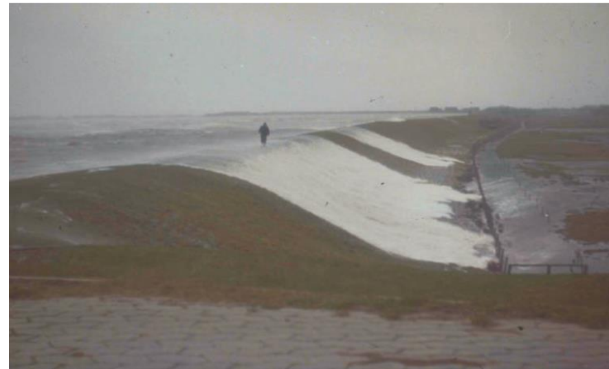
Tracimazione di tipo «green water».
