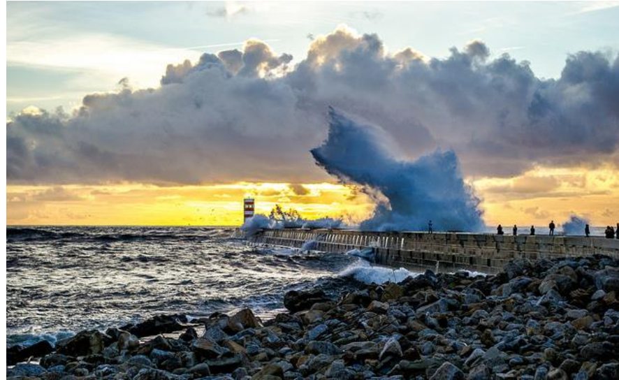
Tracimazione di tipo «white water» oltre una diga costiera a Porto, Portogallo.
