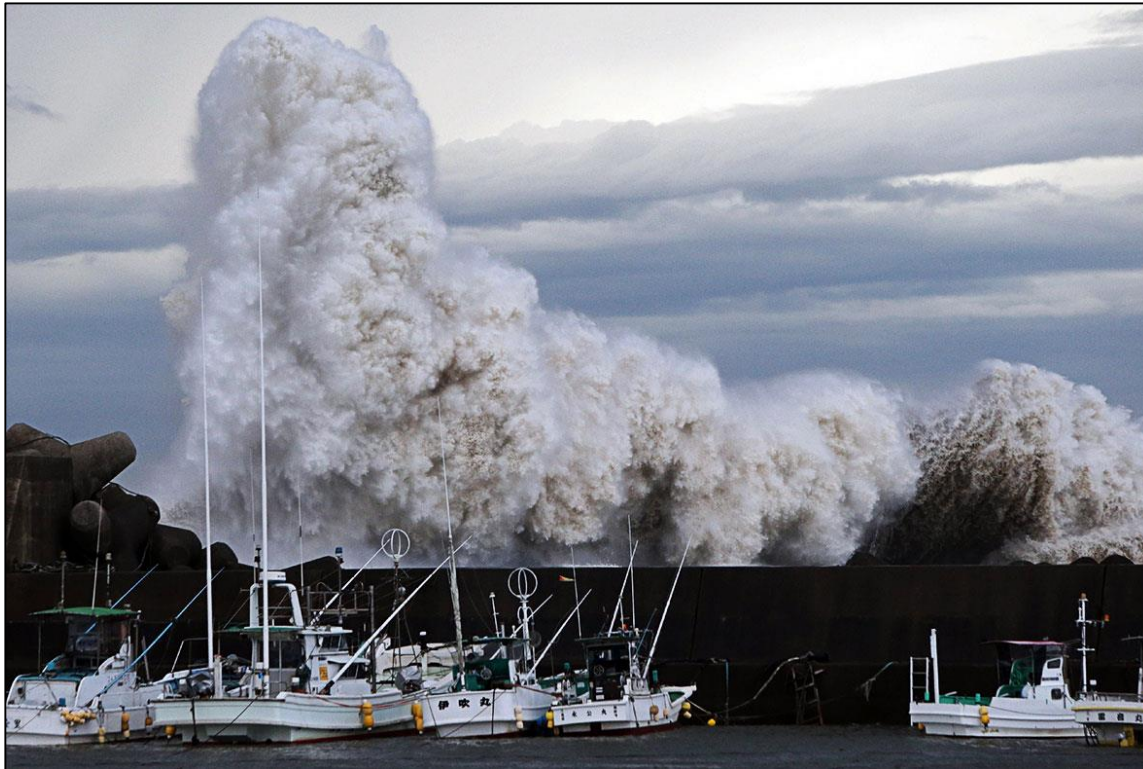
Tracimazione d'onda nel porto di Kiho, Giappone.
