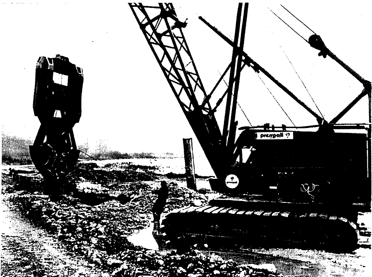
Altro tipo di benna mordente per l'esecuzione dei diaframmi; si noti la particolare carenatura superiore.
